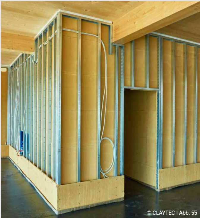
Konstruktion Metallprofile mit Lehmbauplatten
