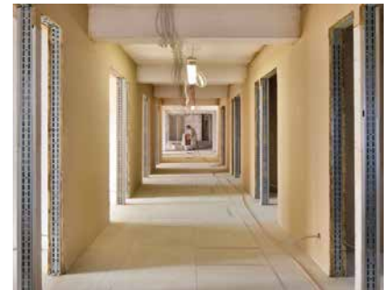
Lehm-Dünnlagen Beschichtung beim BV UN-Campus, Bonn
