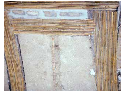
Rohrgewebe St70 auf Holzbalken einer Fachwerkwand
