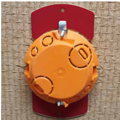
Hohlwanddose montiert, Plattenrückseite
