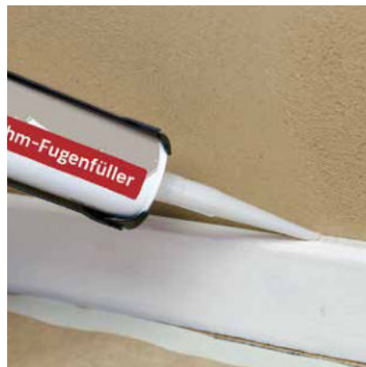
Fugenfüllung mit natur-weiß an einer Sockelleiste
