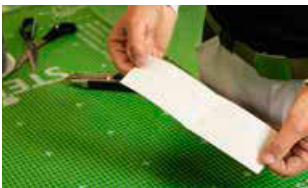
1. Das Klebeband STEICOmulti tape black der Länge nach falten, bis ein deutlicher Falz entsteht
