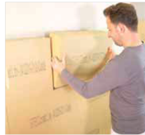
Verlegung kleinformatiger stumpfer Platten
