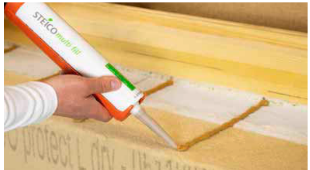
4 Kleben des Keils je nach Einbauhöhe mit STEICOmulti fill in Kleberaupen oder STEICOsecure Base mittels Klebebatzen, e \leq 20,0 cm
