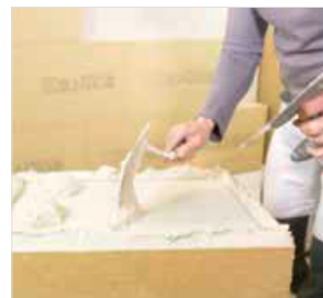
Dämmplatte ankleben auf unebenem Untergrund im Punkt-Wulst-Verfahren
