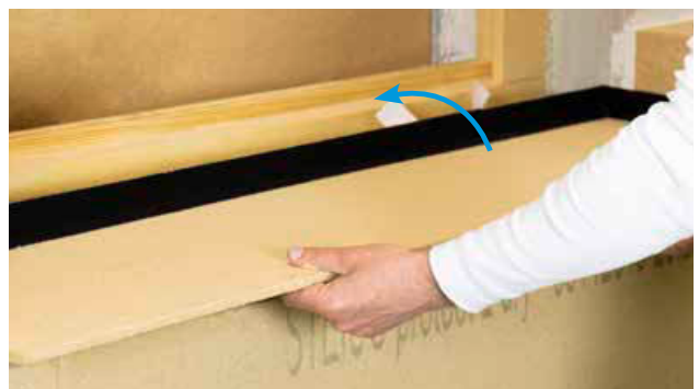
5 Einbau des STEICOtri Holzfaser-Dämmkeils: Unter Druck satt in den Kleber einschwimmen
