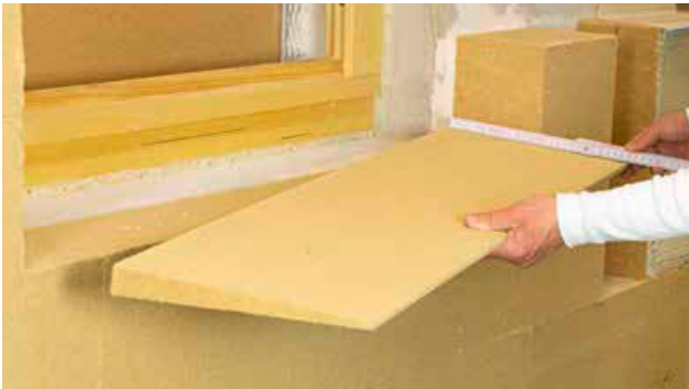
1 Bündiger Zuschnitt des STEICOtri Holzfaser-Dämmkeils auf die passende Länge und Tiefe der Fensteröffnung
